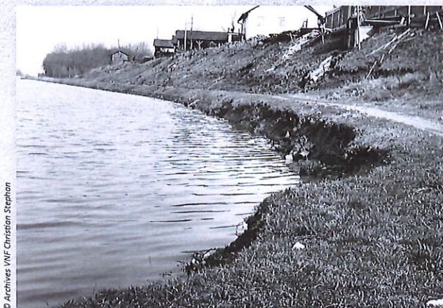
Vue du canal à Hagenbach en 1966 : on distingue une partie des bâtiments de la tuilerie Gessier ainsi que l'état du talus intérieur, non protégé et éboulé, nécessitant des travaux de remise en état.
